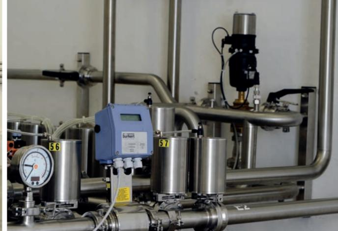
Dosage en continu d'additifs après filtration. Contrôle automatisé des cycles de filtration et de nettoyage.
